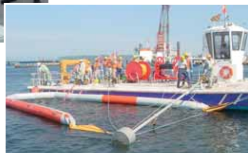
集油フェンスなどを使用して回収
